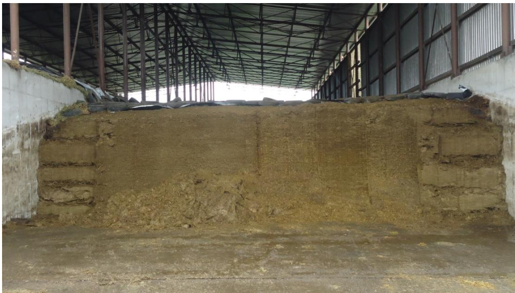
Fotografia 7. Silos przejazdowy zadaszony ułatwia osiągnięcie najwyższej jakości kiszonki oraz minimalizację strat (fot. ITP)
