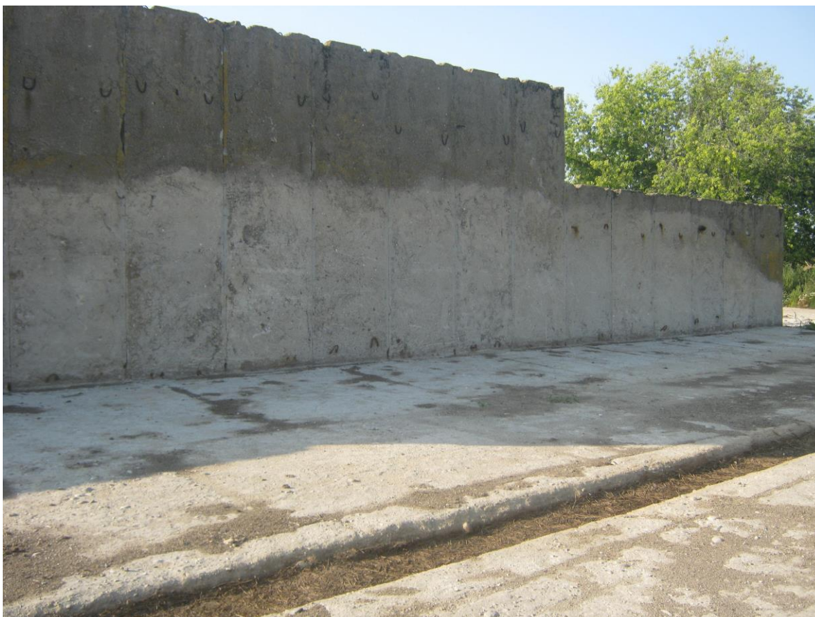
Fotografia 3. Silos betonowy do przechowywania kiszonek (fot. IUNG-PIB)
