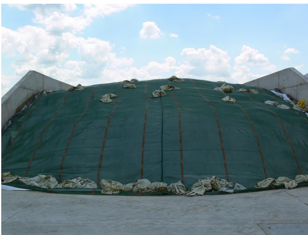
Fotografia 6. Sposób przykrycia kieszonki w silosie przejazdowym (fot. W. Wardal)
