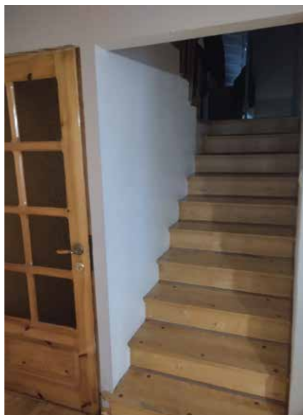
Zdjęcie 7. Schody mogą stanowić poważną barierę dla osób o ograniczonej mobilności. Na zdjęciach schody o dużym nachyleniu, bez spoczników i poręczy. Autor zdjęcia: A. Siewierska, A. Michalska
